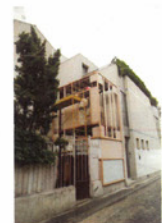
vue du chantier depuis la cour
