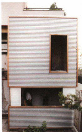
vue du chantier depuis le passage
